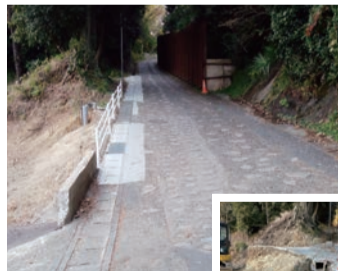
通学路脇側溝工事
