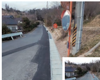
側溝新設工事
