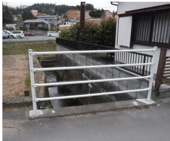
上荒川 用水路柵設置工事
