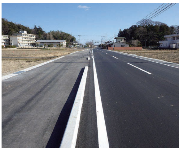
中神谷 道路拡張工事
