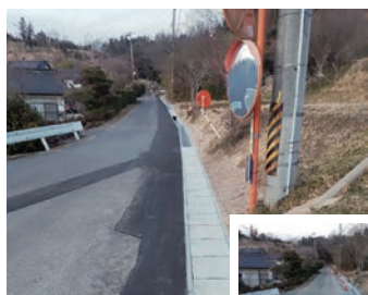
側溝新設工事
