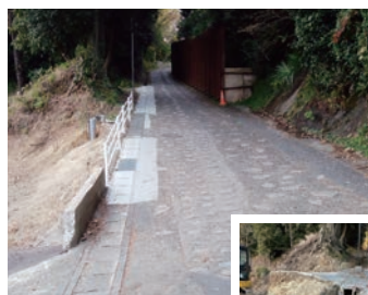
通学路脇側溝工事
