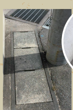
雨水の処理が追い 付かなくなり、吹 き上げられた側溝 の蓋を補修処理
