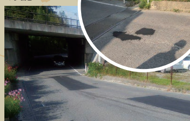
局部改良工事 の実施
