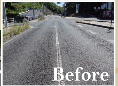
平鎌田 道路補修工事
