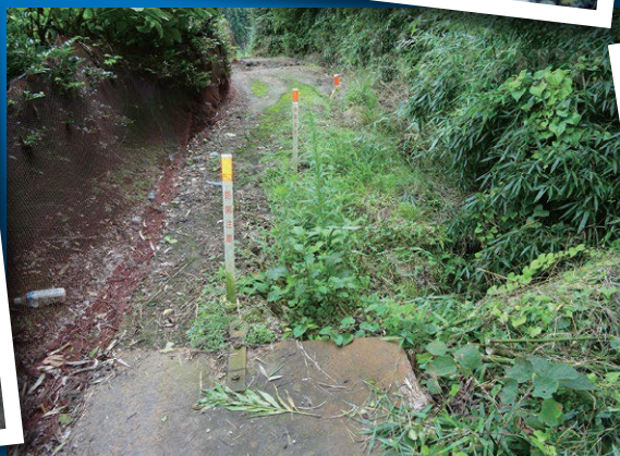
平36区 排水グレーチング設置工事
