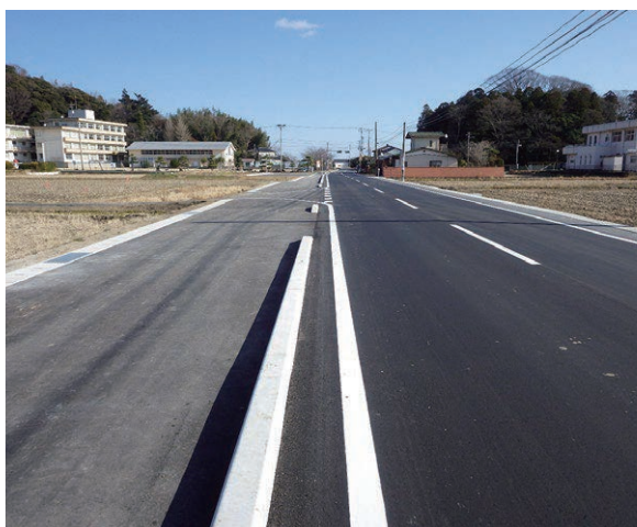
中神谷 道路拡張工事
