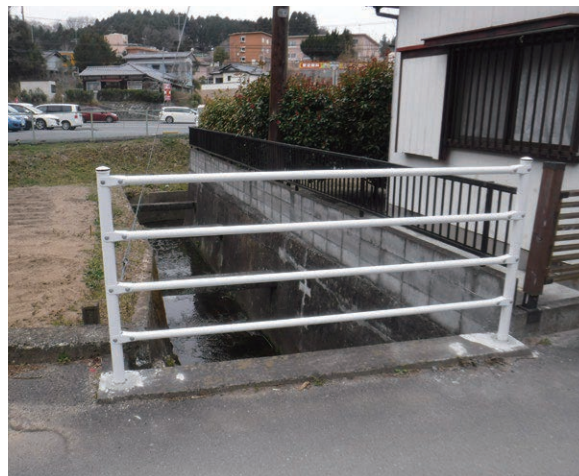
上荒川 用水路柵設置工事
